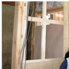
(左写真)既存の小舞壁室内仕上材の合板を剥がすと小舞が出てくる。(右写真)小舞壁と同一ような粘りのある性能を示すあら壁パネルの施工をしている。
