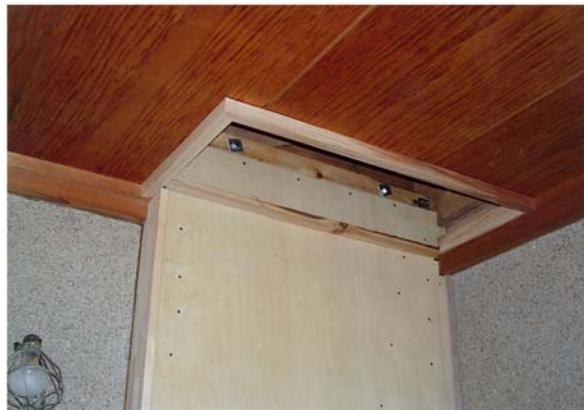
基礎から2階の梁に達する壁補強壁を補強する部分の基礎を補強した(上)。補強箇所の上部は2階の梁に達し、接合部に金具を取り付けた。
