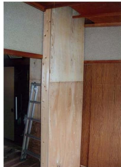
筋かいと構造用合板による壁補強壁を補強する部分に筋かいを設けた(上)。その上から、構造用合板を打ち付けて補強した(下)。
