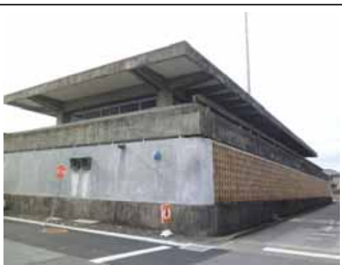
墨会館（一宮市） 丹下健三設計のRC造事務所建築。艶金興業の事務所として使われてきたが、繊維産業からの撤退に伴い売却。一宮市が購入し、公民館として活用する予定。
