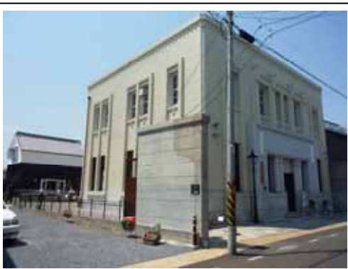
旧津島信用金庫（津島市） 古い町家が残る本町通にある近代建築。所有者から市が寄付を受け、津島市観光交流センター（愛称：まつりの館 津島屋）として活用。NPO法人まちづくり津島が運営。
