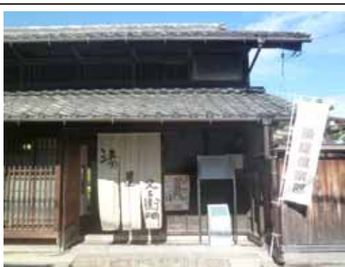
旧湊屋（一宮市） 美濃路起宿の街道沿いの商家の繁栄を伝える大型町家。市民団体「湊屋倶楽部」が管理・活用を行い、湊屋倶楽部茶屋（水・土・日）を開店。
