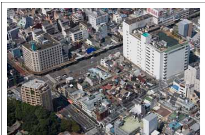
低層木造家屋の密集する高島屋南地区 (写真提供：(株)エスエス名古屋)
