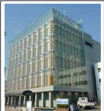
丸美産業本社ビル。2008年7月完成。1階はRC造であるが、2〜5階の柱に木質ハイブリッド集成材（カラマツ集成材の中にH型鋼を内蔵した1時間耐火部材）が用いられており、木のビルとしての異彩を放つ。
