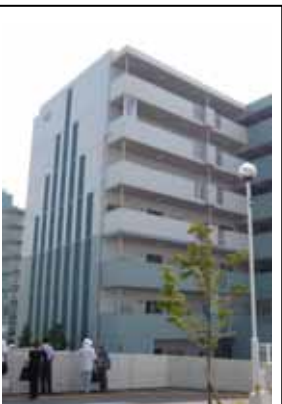
部会の見学会では、建替事業が行われている県営平針住宅を視察。
