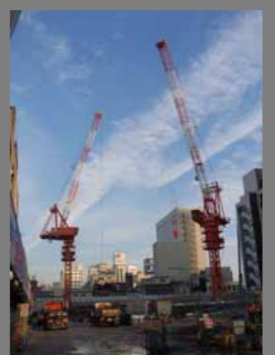
H24年秋竣工に向け工事は進む
