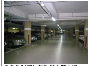
新たに設けられた地下駐車場。
