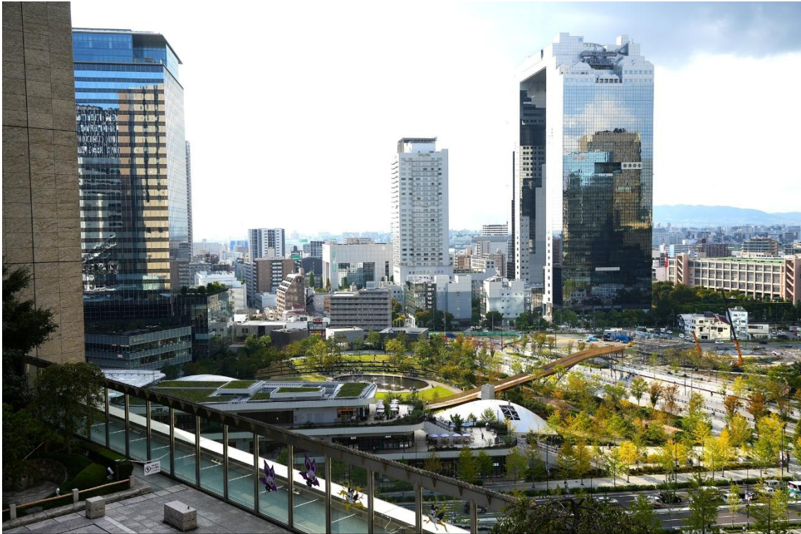
大阪駅ノースゲートビルディングからみたグラングリーンの景観。ノースパークは工事中である。
