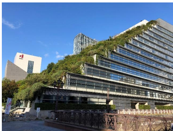
側面から見たクロス福岡。階段状庭園の様子が見て取れる。一皮むけば・・・
