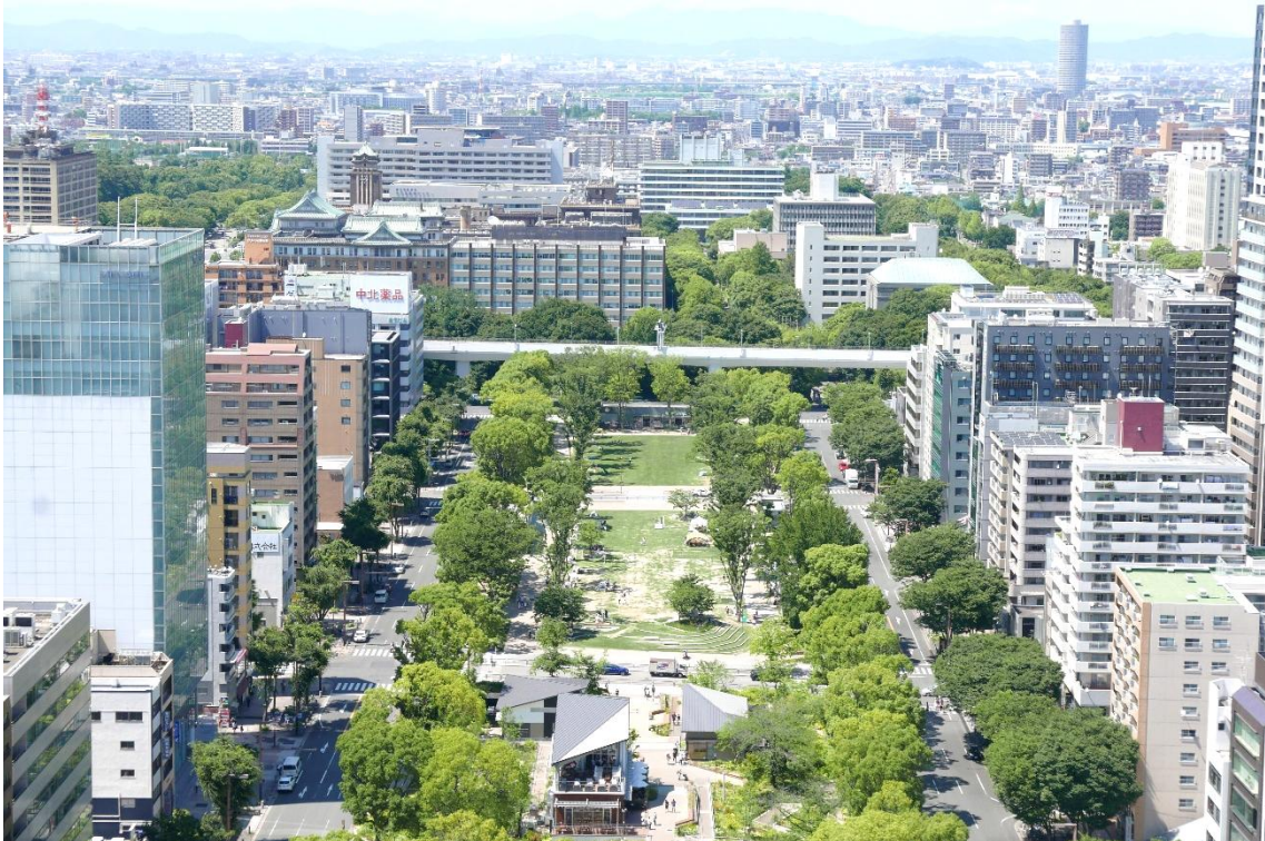
名古屋テレビ塔より北側の久屋大通を眺める。パークPFIで芝生広場や商業施設が建っている。
