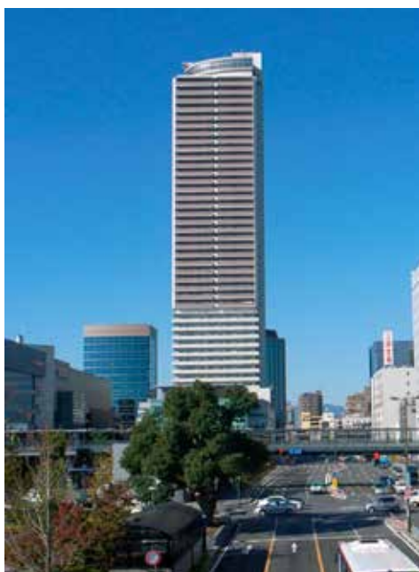
岐阜シティ・タワー43（2007年竣工）
